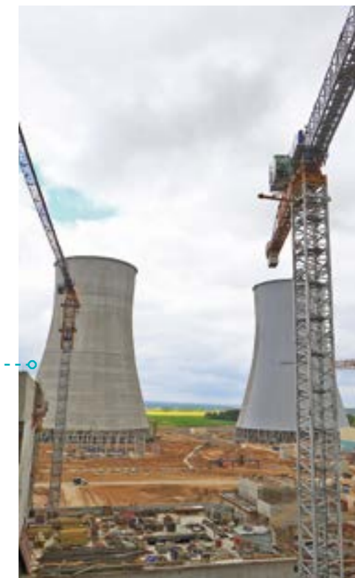
Строительство Белорусской АЭС, май 2017 г.
