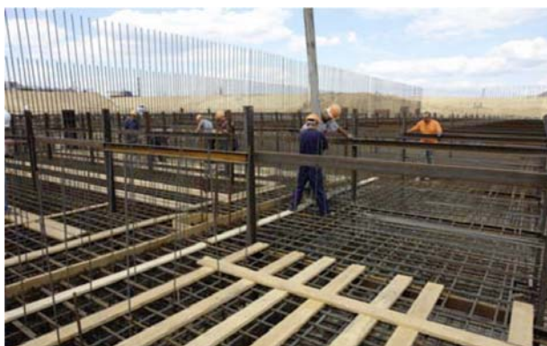
Залит первый бетон в фундаментную плиту здания реактора первого энергоблока Нововоронежской АЭС-2, что ознаменовало начало основного периода строительства НВ АЭС-2»
