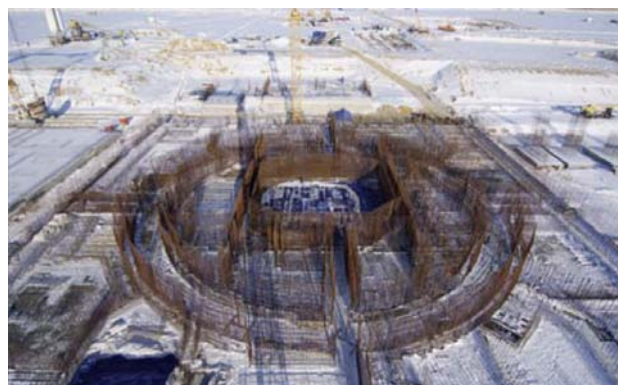
ОАО «Атомэнергопроект» завершило работы по бетонированию фундаментной плиты здания реактора энергоблока №1 Нововоронежской АЭС-2.
