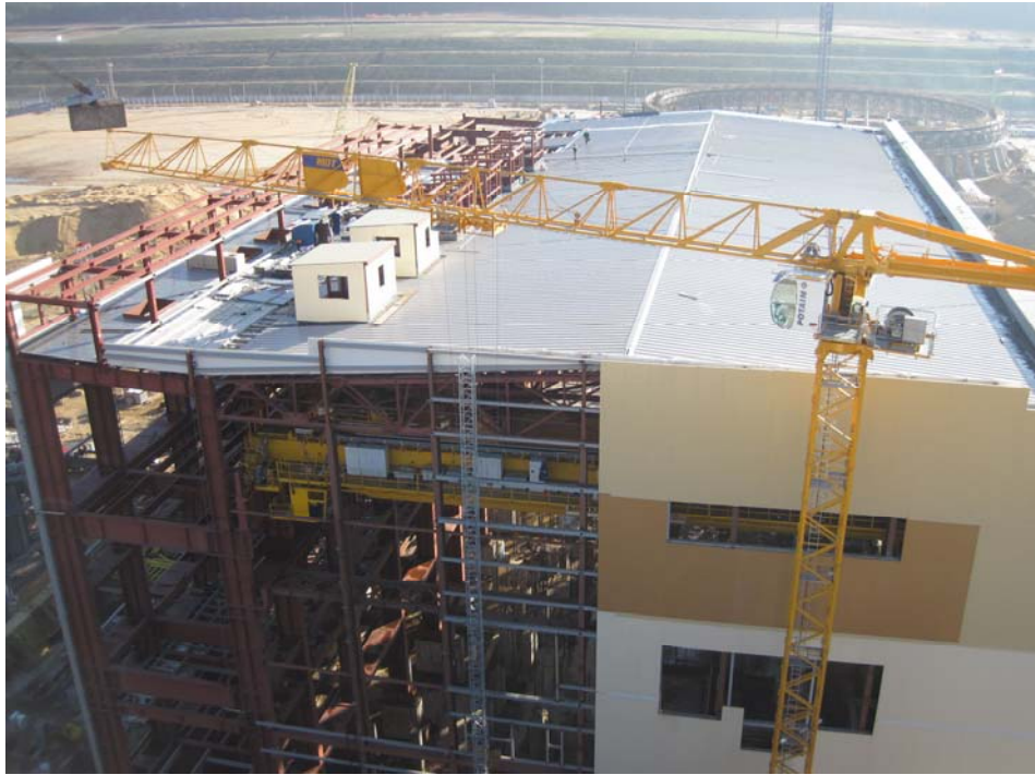
Смонтирован мостовой кран грузоподъемностью 180 т. Завершены работы по монтажу металлоконструкций каркаса здания турбины и стенового ограждения.
