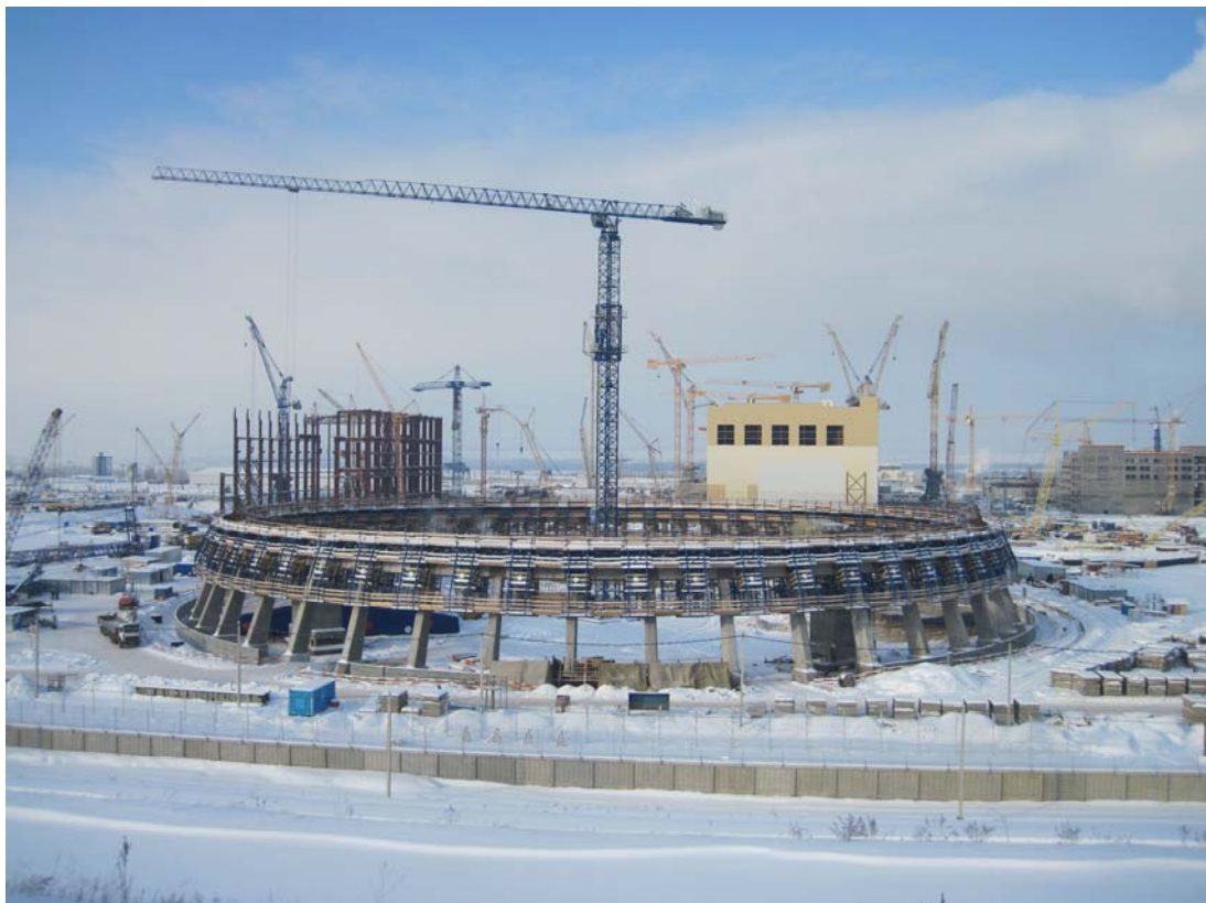
Завершены работы по устройству кольцевого фундамента башенной испарительной градирни, установке опорных колонн на кольцевом фундаменте и устройству нижнего опорного кольца под оболочку (ствол) градирни.
